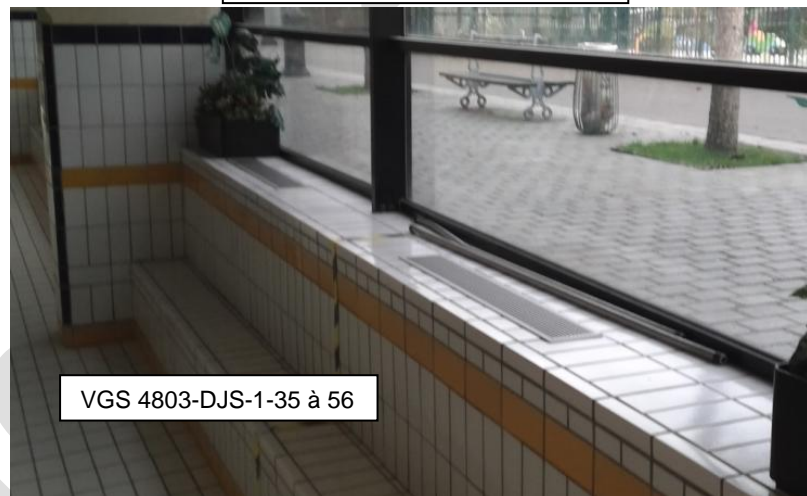
Bouches de soufflage hall bassin
