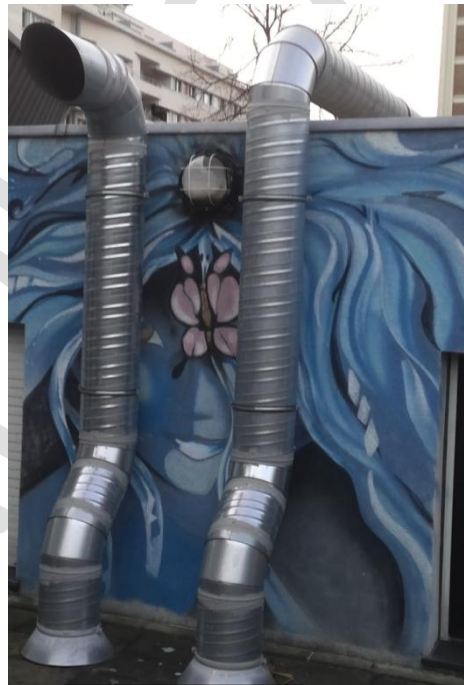
Prise d'air neuf et rejet CTA Vestiaire RDC
