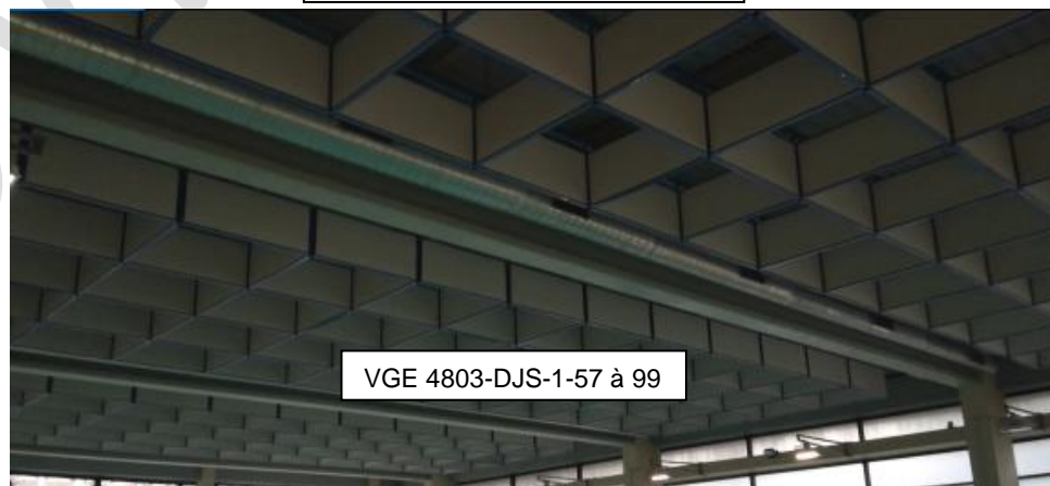
Bouches d'extraction hall bassin
