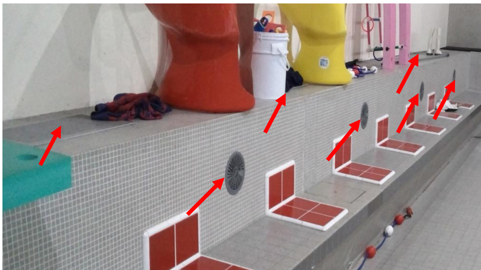
Bouches de soufflage bassin
