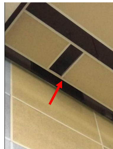
Bouches de reprise bassin (inaccessibles)
