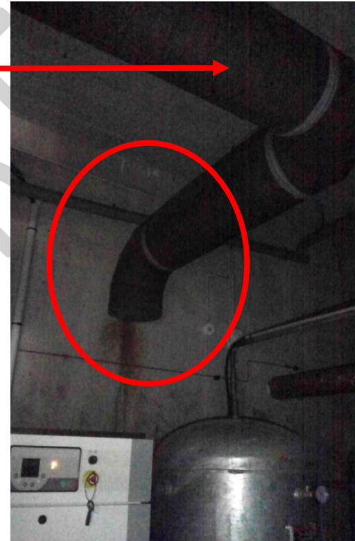
Prise d'air ambiant raccordée à la gaine d'air neuf
