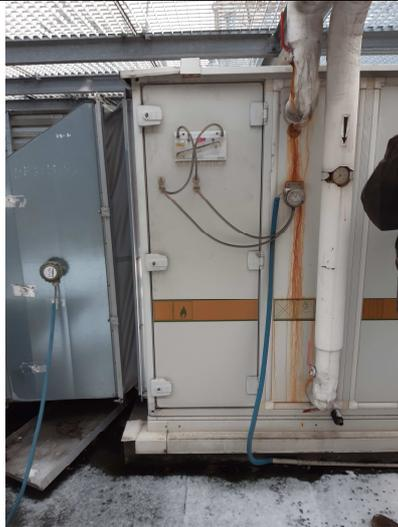
Filtres coupés manuellement – Dépression des filtres non mesurables car les connectiques sont gelés (les connectiques peuvent se casser s'ils sont manipulés)
